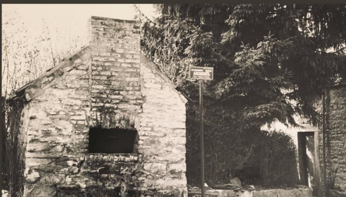
Les fours à pain, qui garantissaient aux Carmes une vie autarcique. Ce fournil est postérieur aux Carmes, il date du 19ème siècle.
