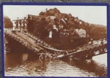
Le pont de France, détruit.
